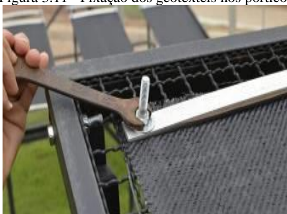
Figura 3.11 - Fixação dos geotêxteis nos pórticos.
