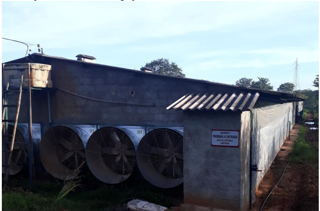
Figura 11: Vista parcial do exterior do galpão climatizado.
