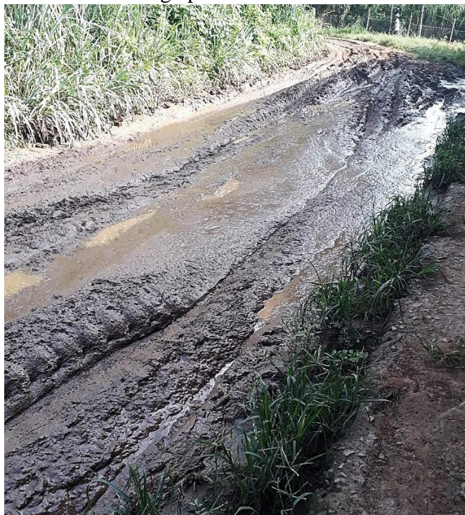
Figura 16: Estrada de acesso a um dos galpões.
