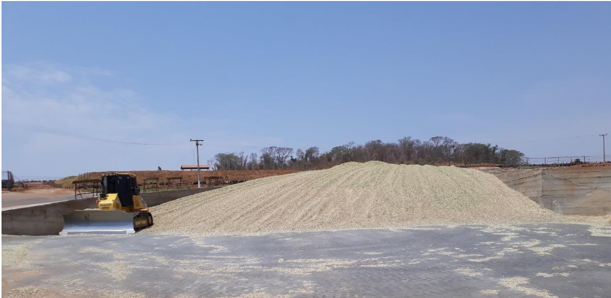
Figura 13 – Processo de enchimento do silo 1.
