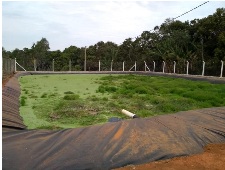
Figura 9 – Lagoa utilizada para armazenamento temporário do efluente drenado dos vasos utilizados no cultivo do tomateiro em estufa na propriedade estudada.
