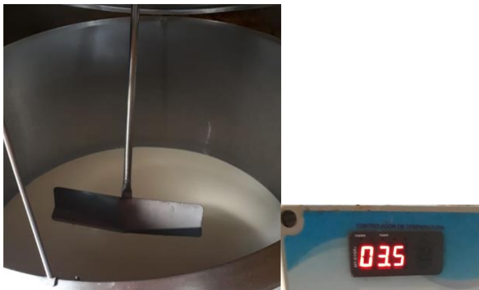
Figura 29: Tanque em funcionamento com regulagem adequada.
