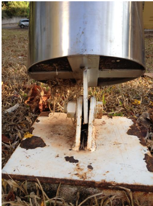
Parafuso em cisalhamento duplo
