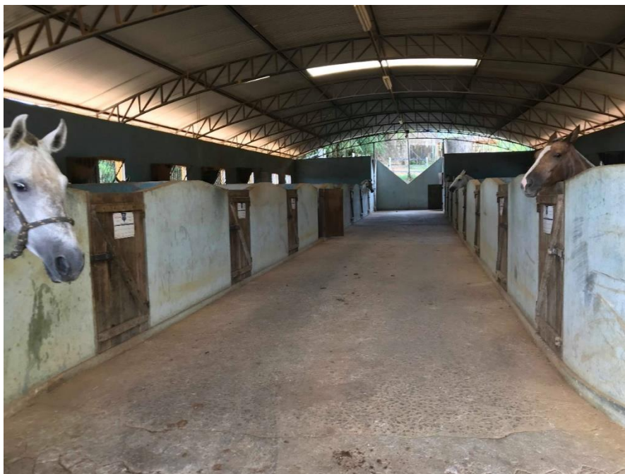
Figura 1: Galpão com baias em alvenaria para acomodação de garanhões e animais de competição
