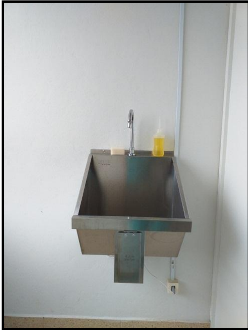
Figura 17 - Vista parcial da ala de paramentação cirúrgica da clínica veterinária Vet & Pet – Lavras.
