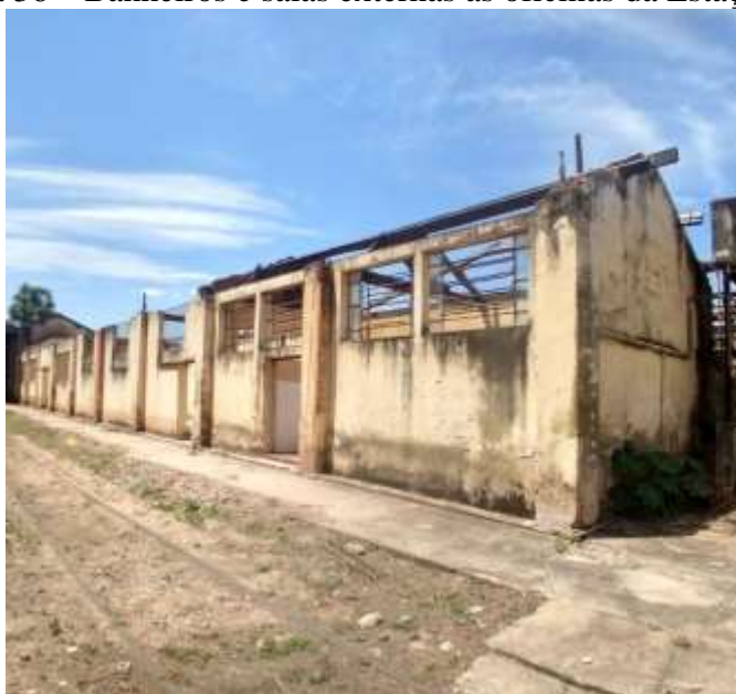
Figura 36 – Banheiros e salas externas as oficinas da Estação Ferroviária
