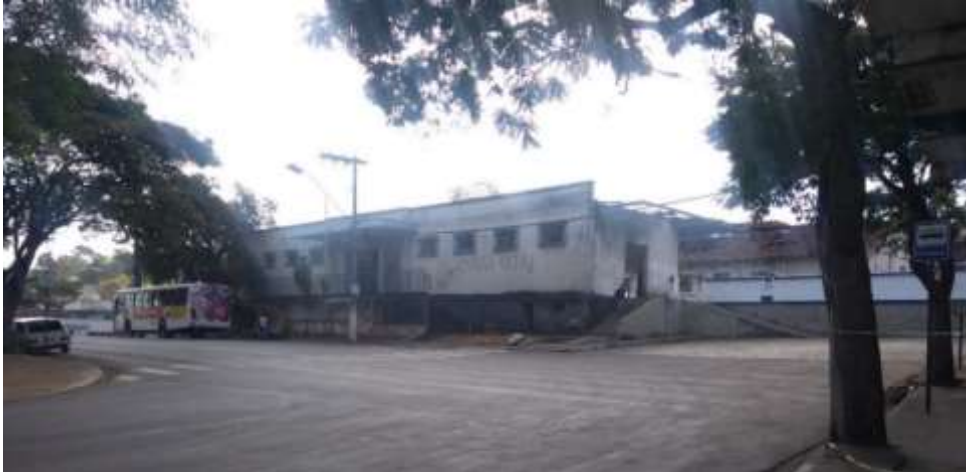
Figura 8 – Fachada do imóvel 1 voltada para a Rua Dr. José Esteves
