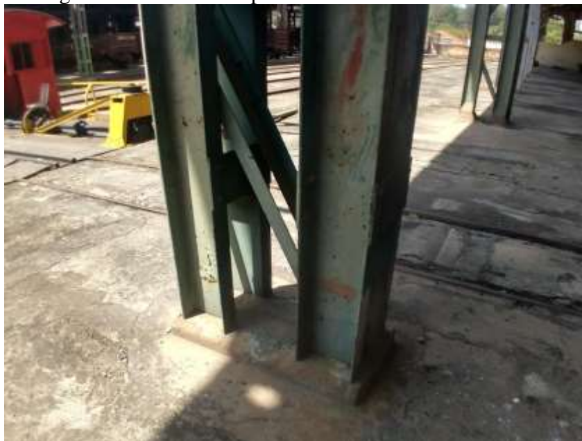
Figura 30 – Detalhe do pilar metálico das oficinas
