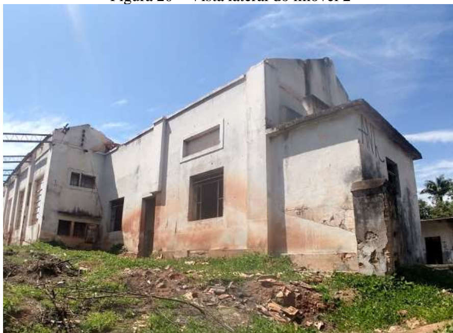
Figura 20 – Vista lateral do imóvel 2
