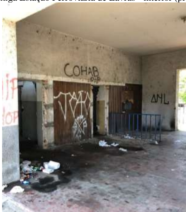
Figura 3 – Antiga Estação Ferroviária de Lavras - interior (prédio principal)
