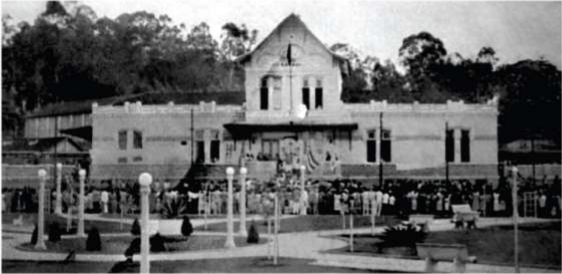
Figura 15 – Estação Ferroviária e Praça Dr. José Esteves nos anos de 1940
