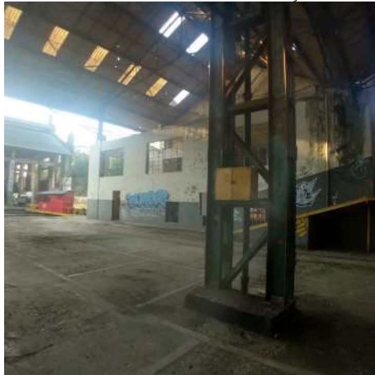
Figura 32 – Detalhe interior da maior oficina da Estação Ferroviária
