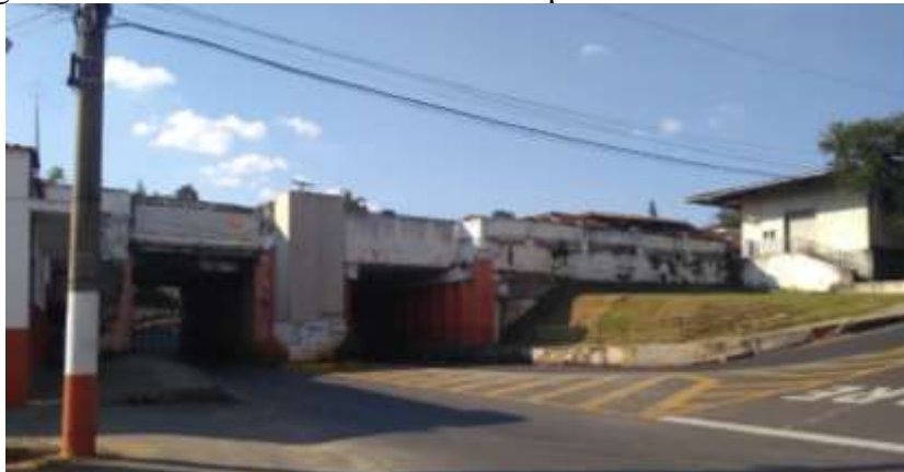
Figura 10 – Fachada do imóvel 1 voltada para a Rua Custódio Moreira
