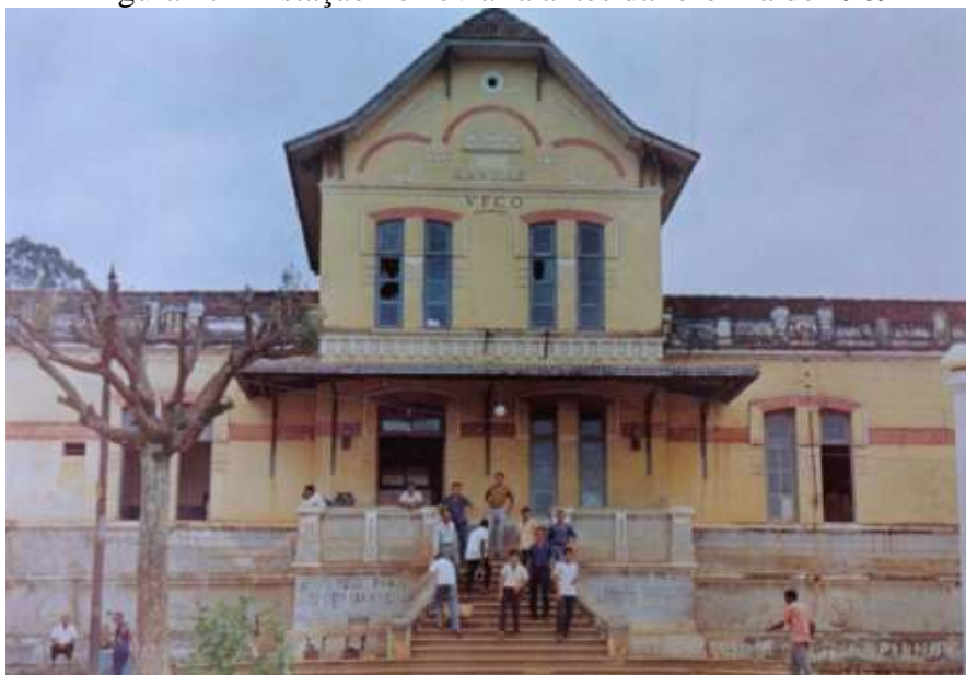
Figura 17 – Estação Ferroviária antes da reforma de 1969
