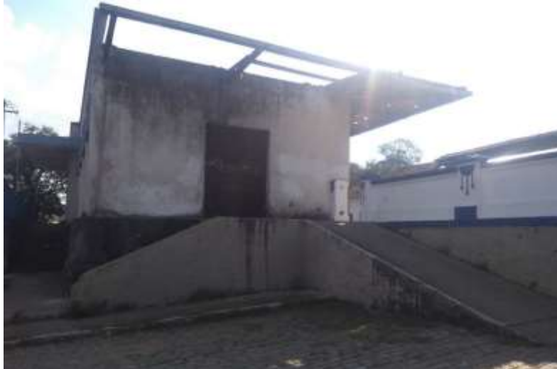
Figura 9 – Fachada do imóvel 1 voltada para a Rua Pedro Sales
