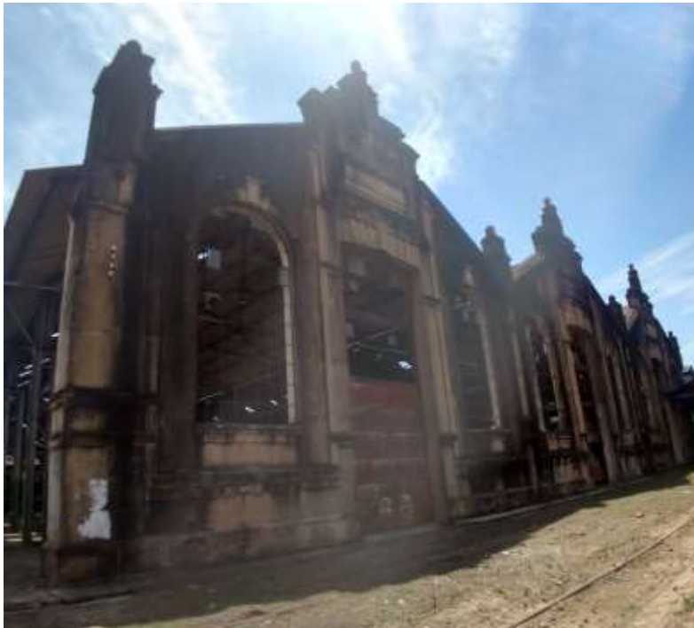
Figura 6 – Oficinas (galpões) da Estação Ferroviária de Lavras
