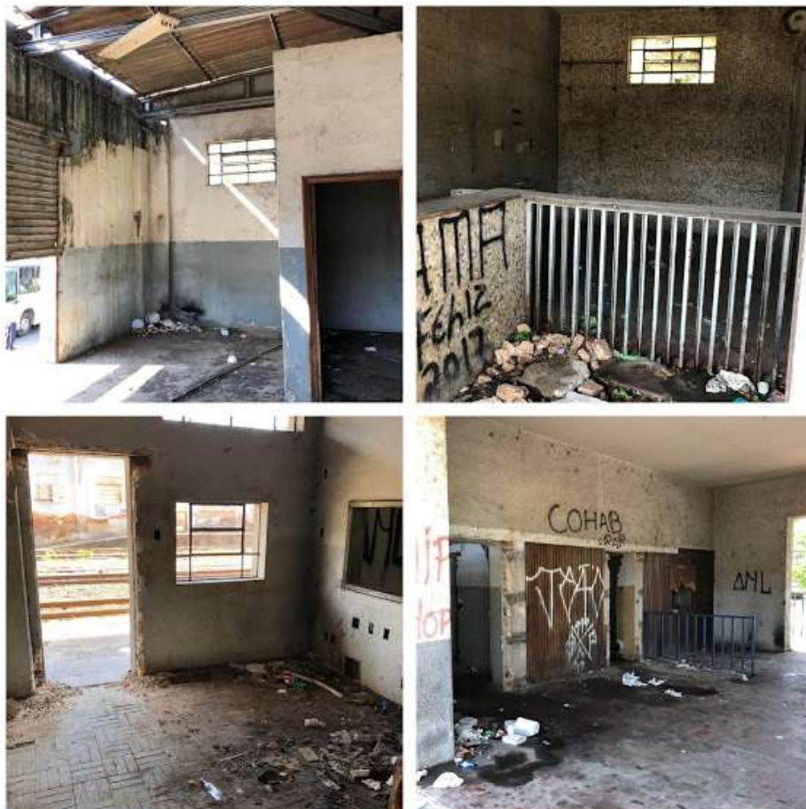
Figura 12 – Interior do imóvel 1 da Estação Ferroviária
