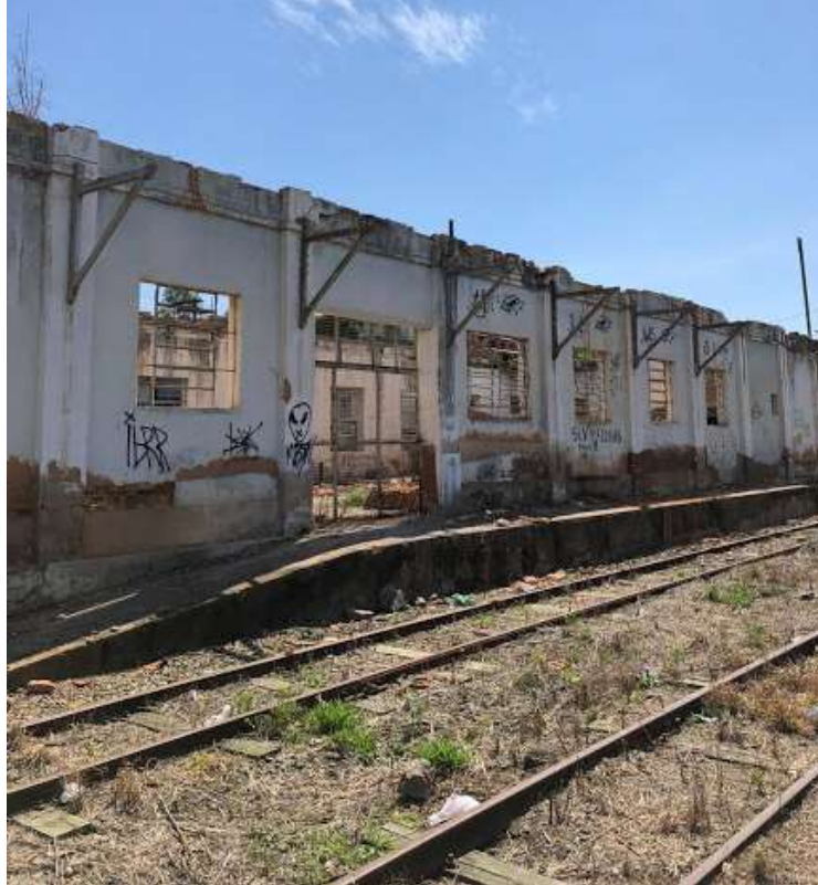
Figura 19 – Fachada do imóvel 2 voltada para a linha férrea
