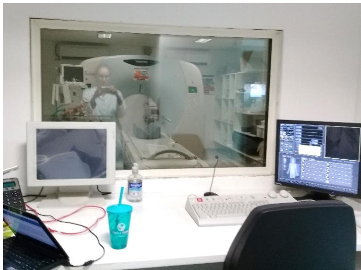
Figura 6 – Vista parcial da sala de controle de exame de Tomografia Computadorizada do Hospital Veterinário Cães e Gatos 24 Horas, em Osasco/SP.
