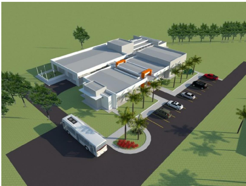
Figura 1 – Projeto de construção do CEPENpet.
