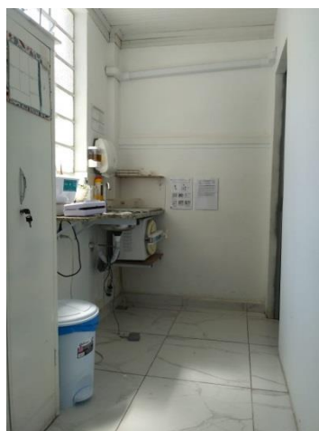
Figura 14 - Corredor de acesso ao centro cirúrgico
