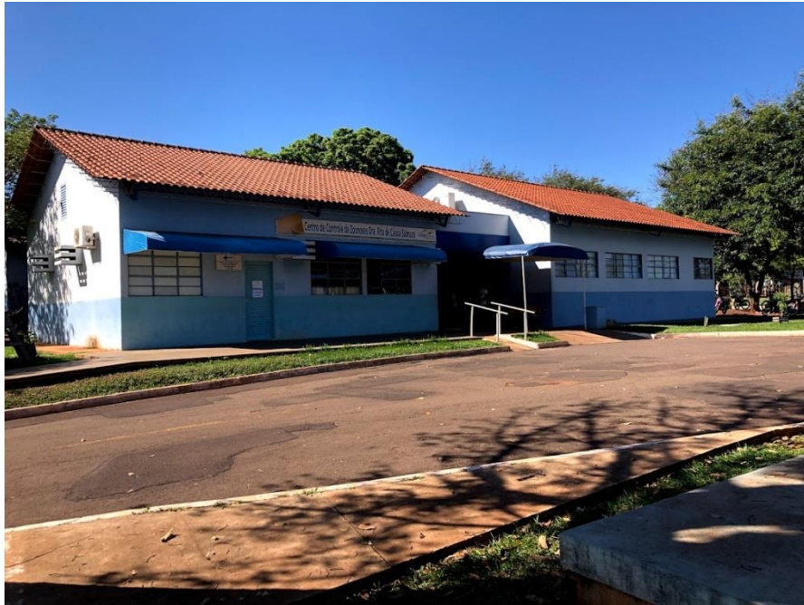
Figura 2- Fachada da Coordenadoria de Controle de Zoonoses de Campo Grande, MS
