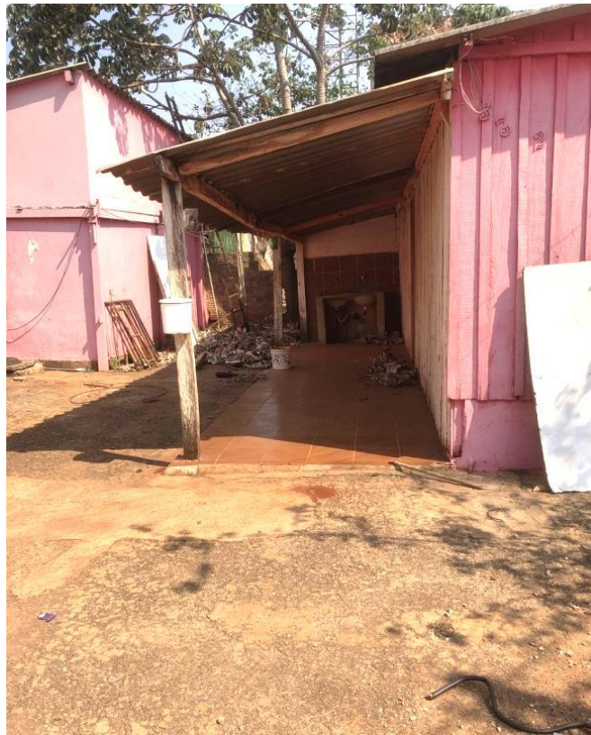
Figura 21 - Imóvel edificado abandonado inspecionado pelo Serviço de Controlde de Roedores, Animais Peçonhentos e Sinantrópicos em setembro de 2019.
