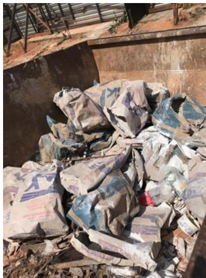
Figura 9 - Sacos de papel de cimento e cal.
