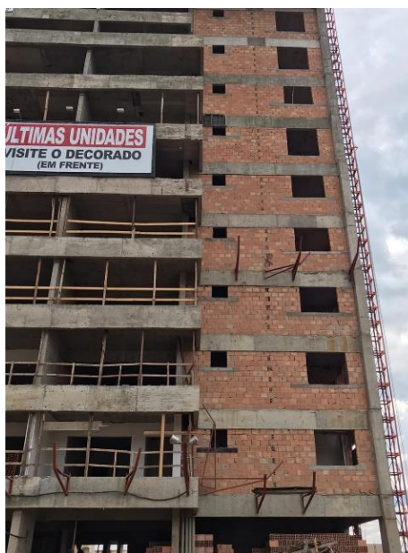
Figura 8 - Vergas e contravergas da obra.
