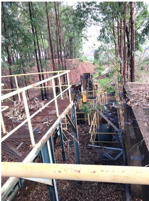
Figura 13 - Britador de entulho localizado em área disponibilizada pela prefeitura.
