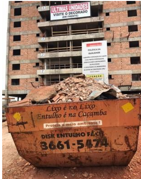
Figura 10 - Acondicionamento dos resíduos em caçamba.
