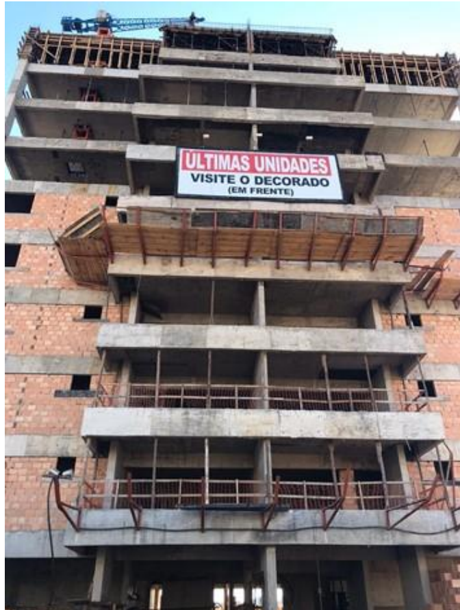
Figura 3 - Edifício em estudo situado na cidade de Araxá, MG.
