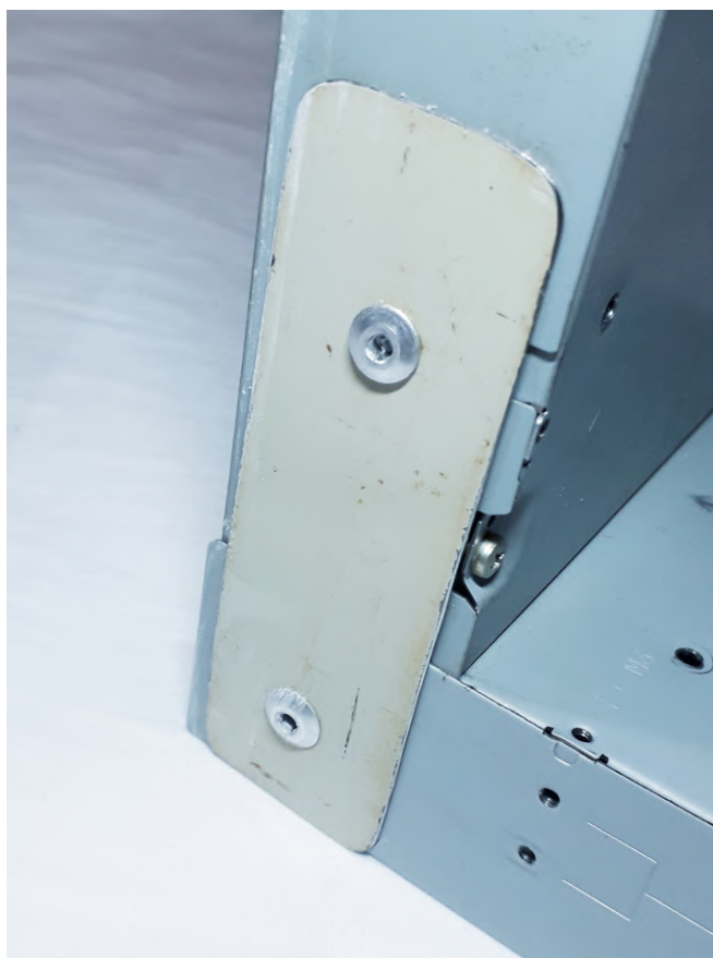
Figura 4.6 – Detalhe da fixação
