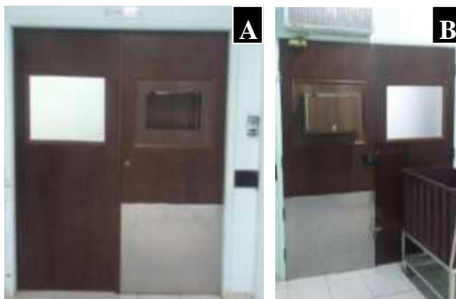
Figura 5 - Vista da porta principal de acesso ao bloco cirúrgico pelo lado externo (A) e pelo lado interno (B) do HVGLN da FCAV/UNESP - Jaboticabal/SP.
