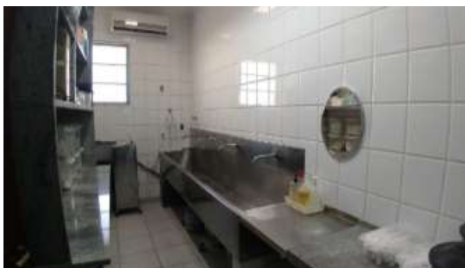
Figura 7 - Vista parcial da sala de paramentação do bloco cirúrgico do HVGLN da FCAV/UNESP - Jaboticabal/SP.
