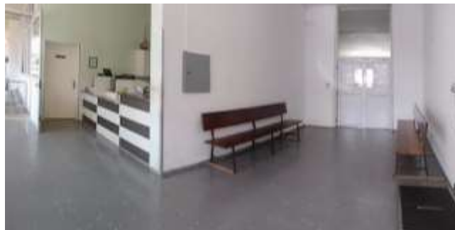
Figura 9 - Vista parcial da recepção do HV da UFPR - Curitiba/PR.
