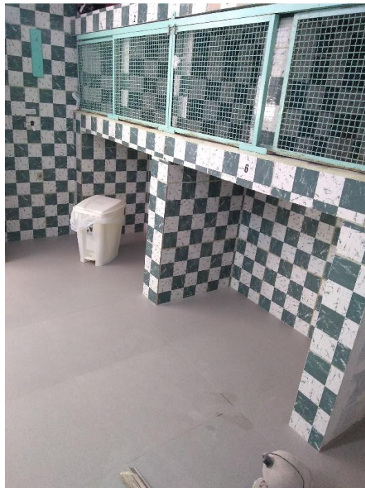
Figura 10 - Vista parcial da Internação III da UNIVET
