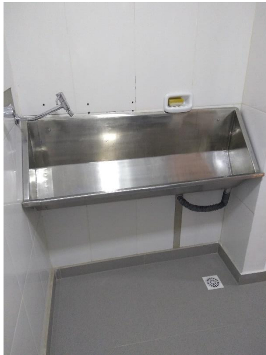
Figura 22 - Vista parcial do Centro Cirúrgico da UNIVET (parte 3)
