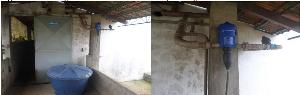
Figura 1. Caixa d'água e bomba utilizada na mediação via água.
