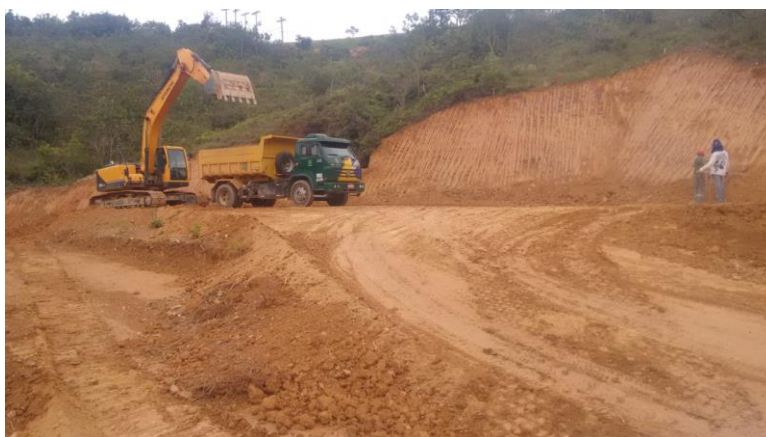
Figura 9 - Obra do loteamento em Nova Lima – MG.
