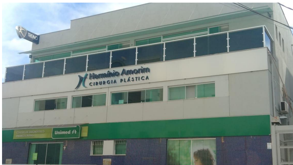
Figura 1 – Fachada do Edifício Hermínio Amorim – Cirurgia Plástica
