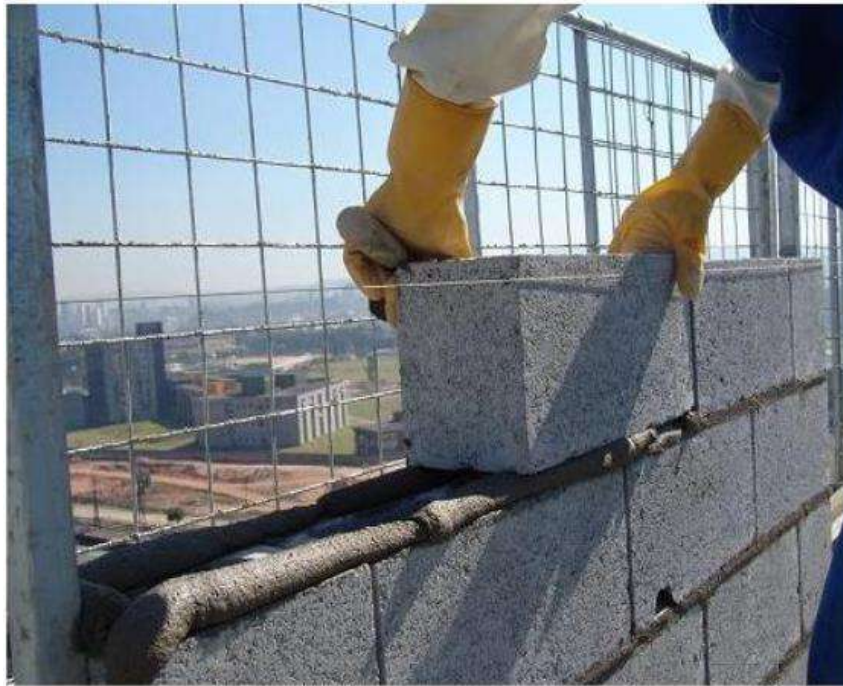
Figura 6 - Blocos de concreto.
