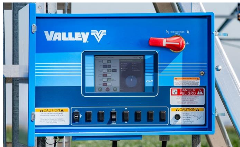
Figura 3 – Painel de controle do pivô.
