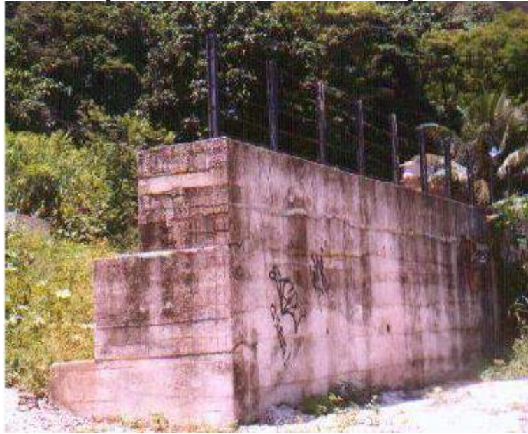
Figura 2.5 – Muro de concreto ciclópico.
