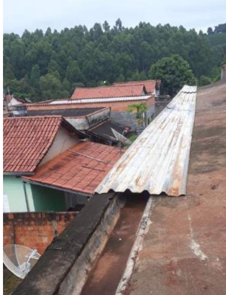
Figura 4.25 – Telhas metálicas sobre canaleta de crista.
