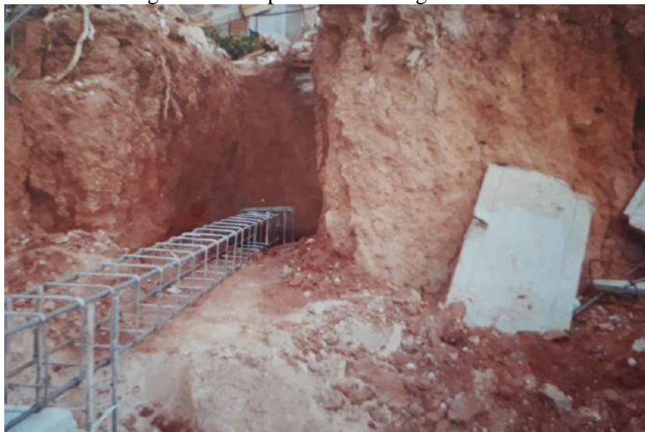
Figura 4.2 – Sapata isolada e viga baldrame
