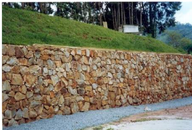
Figura 2.3 – Muro de alvenaria de blocos de rocha sem argamassa.
