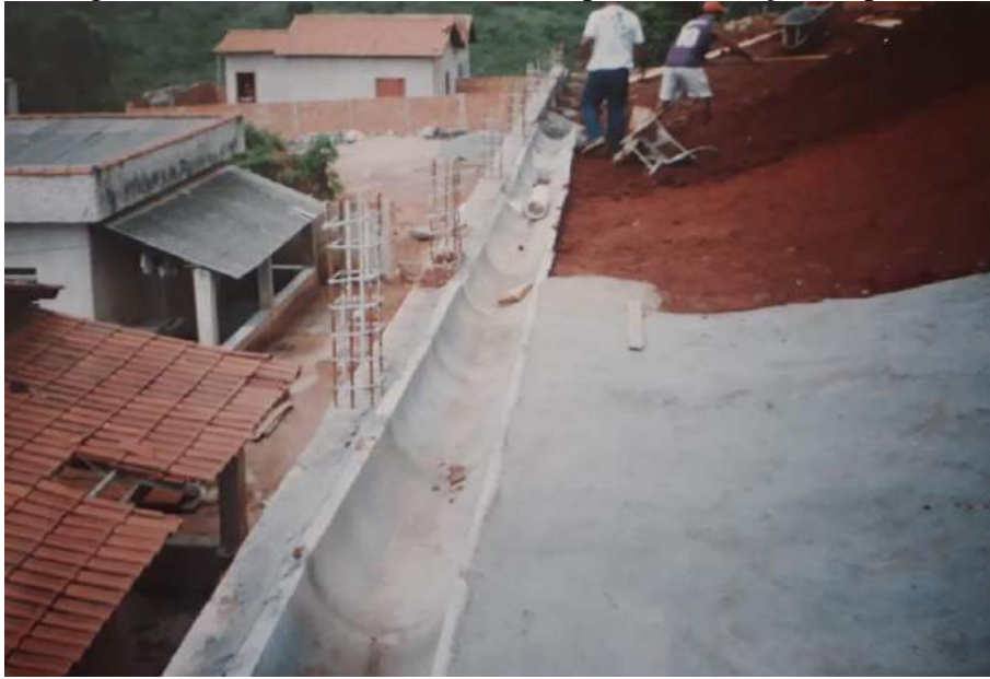
Figura 4.11 – Canaleta de Crista e impermeabilização do platô.
