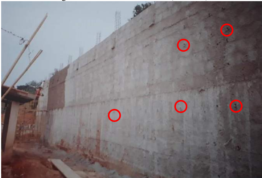
Figura 4.8 – Tubos horizontais (barbacãs).
