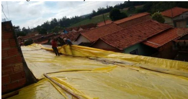
Figura 4.24 – Instalação da lona no platô do muro.
