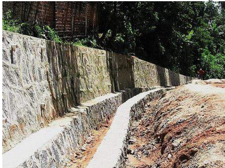
Figura 2.4 – Muro de alvenaria de blocos de rocha com argamassa.
