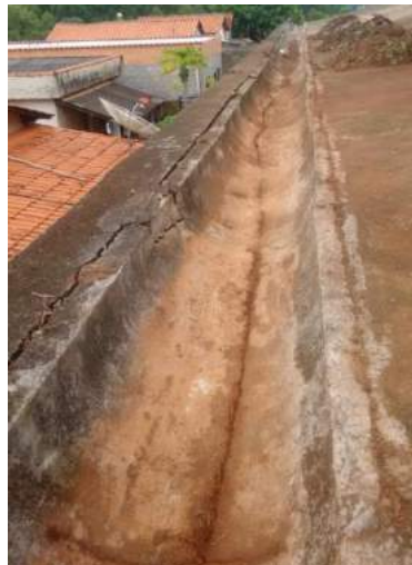
Figura 4.20 – Rotação da canaleta.
