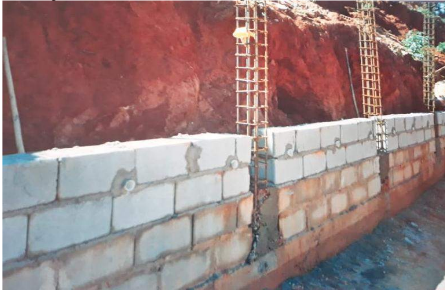
Figura 4.3 – Bloco de concreto, pilares armados e barbacãs.
