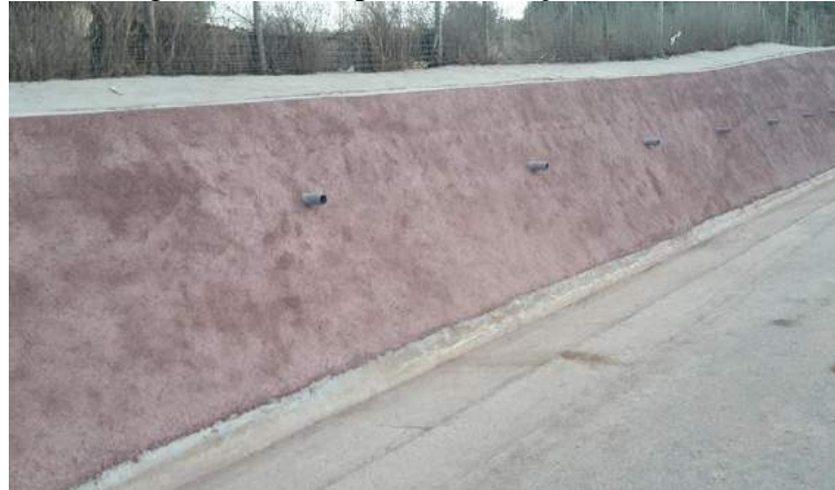
Figura 2.14 – Impermeabilização de talude.
