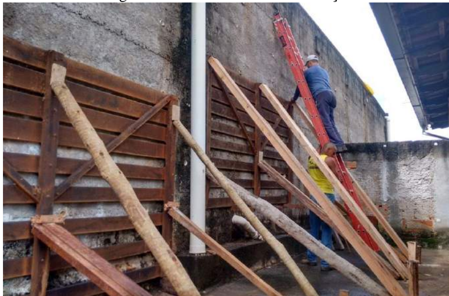
Figura 4.26 – Escoramento de reforço.
