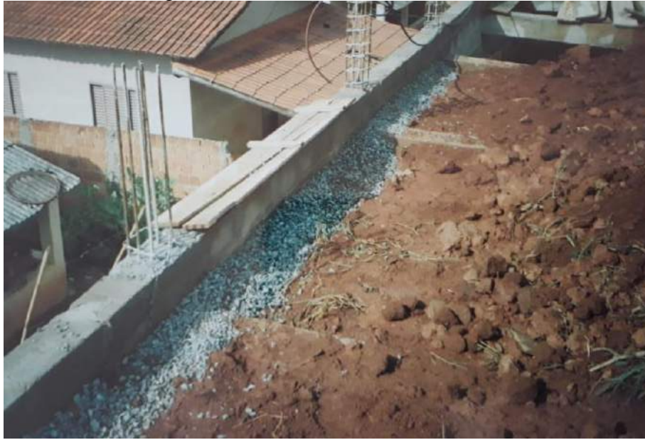
Figura 4.7 – Camada drenante em brita.
