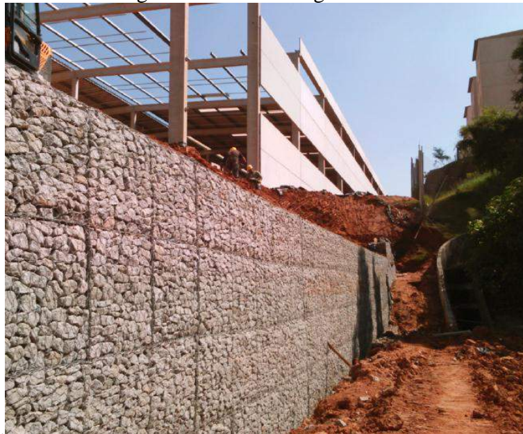
Figura 2.7 – Muro de gabião.
