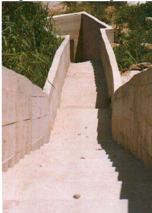
Figura 2.15 – Canaleta longitudinal.
