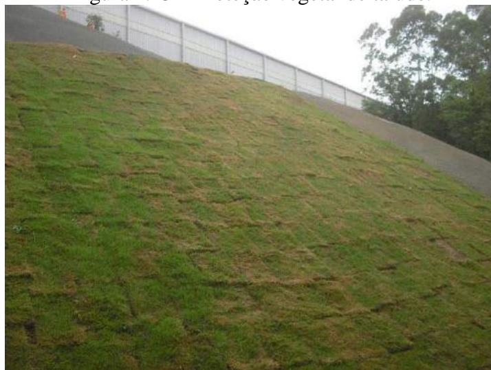
Figura 2.13 – Proteção vegetal de talude.
