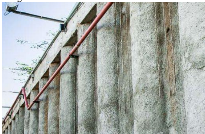
Figura 2 – Cortina de estacas de concreto armado
