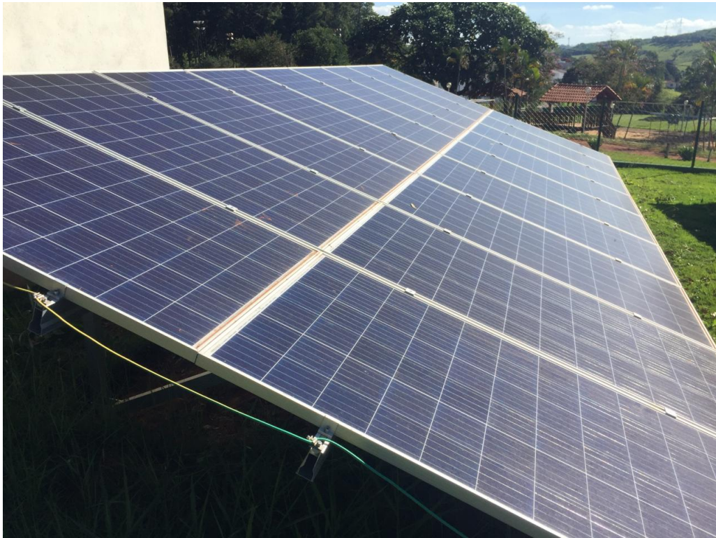
Figura 3.6 – Primeiro sistema com 18 Placas solares distribuídos.
