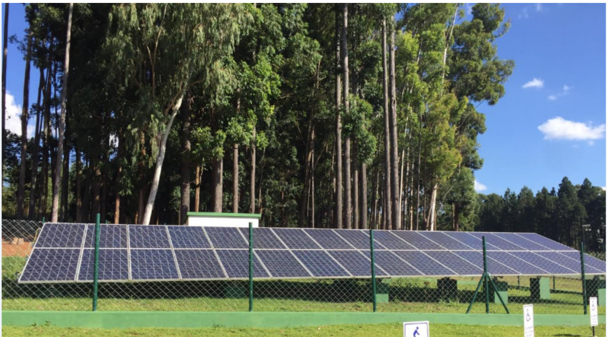
Figura 3.7 – Segundo e o terceiro sistema, cada qual com 16 Placas solares distribuidos para cada.
