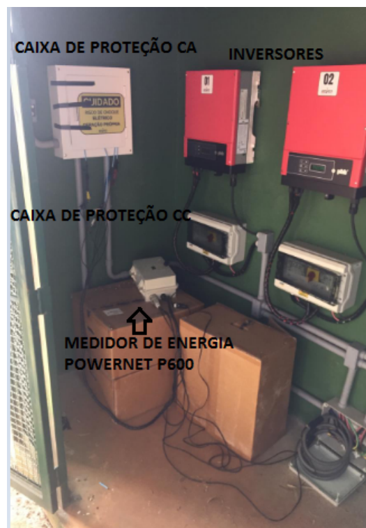
Figura 3.11 – Montagem em campo do sistema de medição de energia na ADUFLA.
