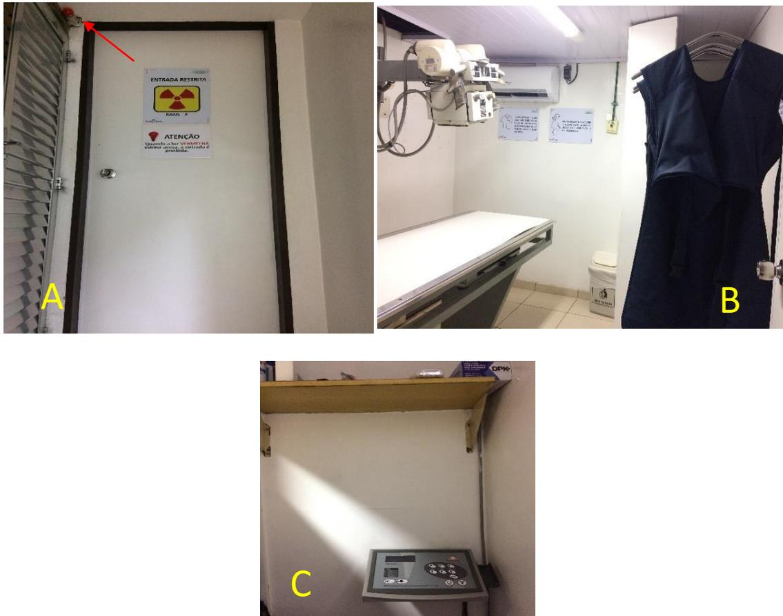
Legenda: Porta da sala de raio-x com avisos em destaque e lâmpada de alerta indicada pela seta vermelha (A). Visão do equipamento de raio X e das vestes plumbíferas que serviam para proteção (B). Painel de controle do aparelho de raio x, que possuía um pedal no chão (não visível na imagem) para ser disparado a distância (C).
