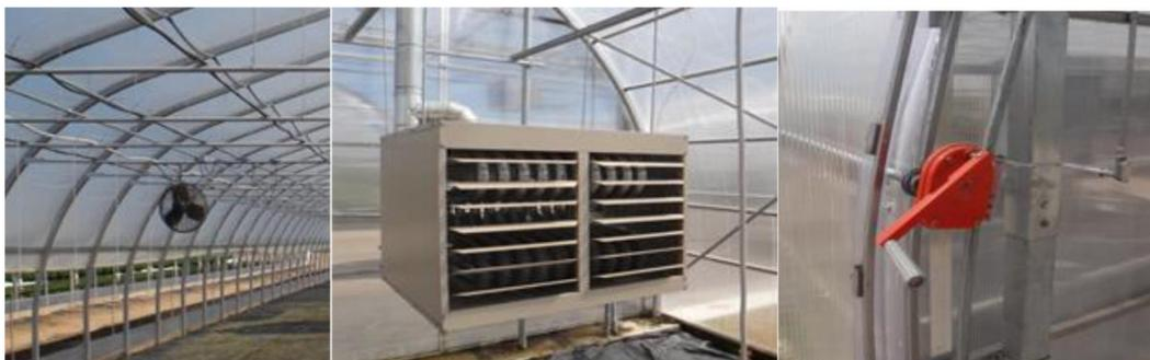
Figura 20 - Sistema de ventilação e controle de temperatura
