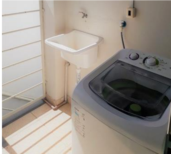
Figura 8- Lavanderia, na Clínica Veterinária Vet&Pet.
