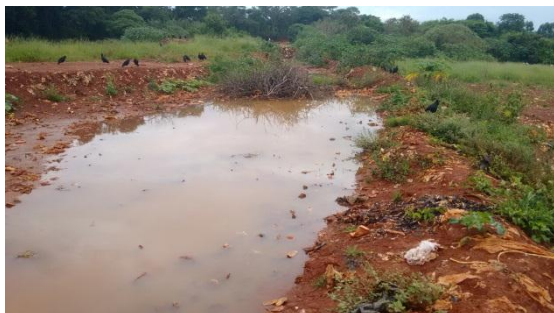
Figura 24 - Dique de contenção de água de chuva.
