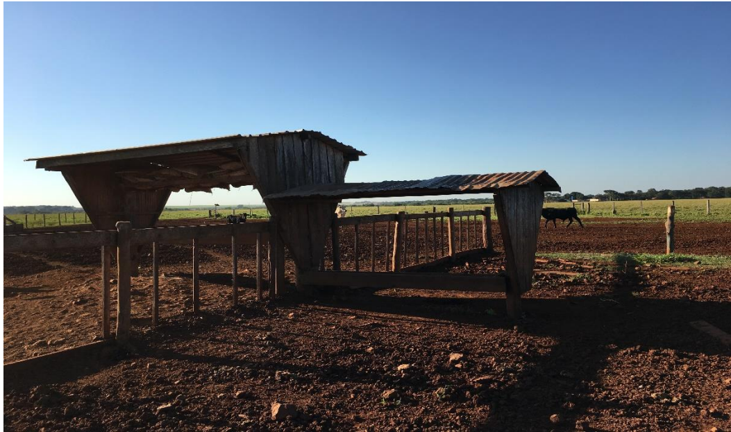
Figura 19 – Estrutura de creep feeding .
