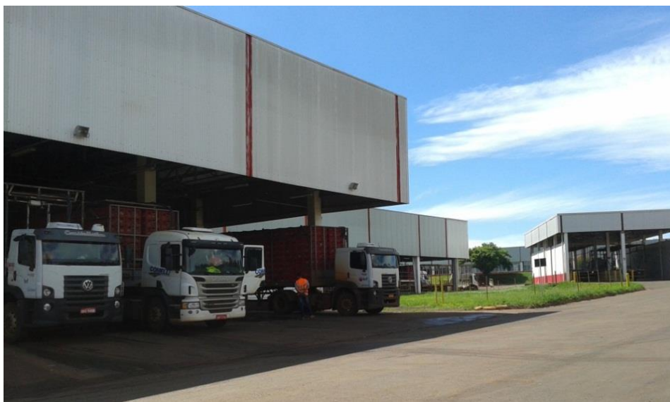
Figura 04 – Plataforma de recepção e descarregamento dos caminhões, pátio para limpeza e higienização.
