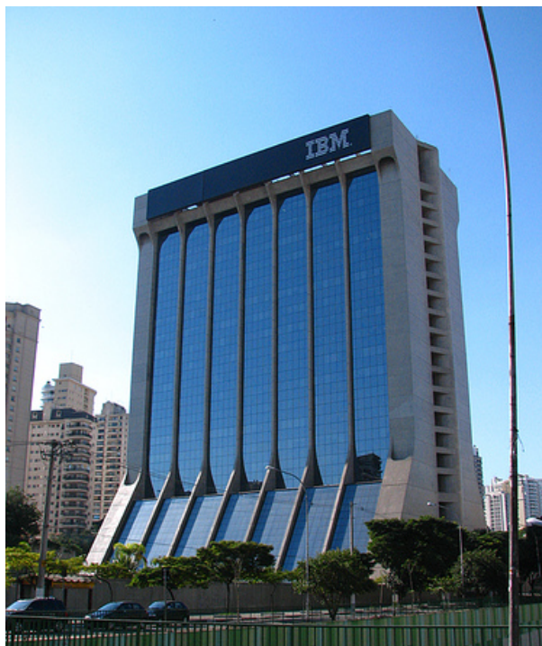
Figura 2 - Edifício da IBM Brasi
