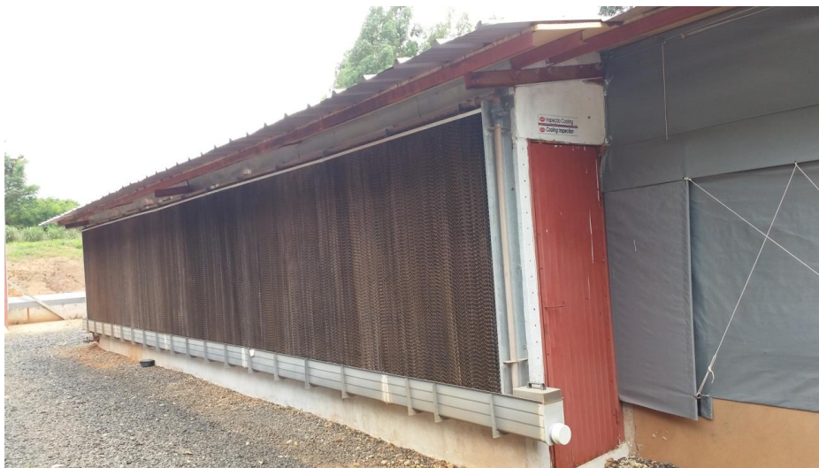
Figura 5. Placas evaporativas de celulose
