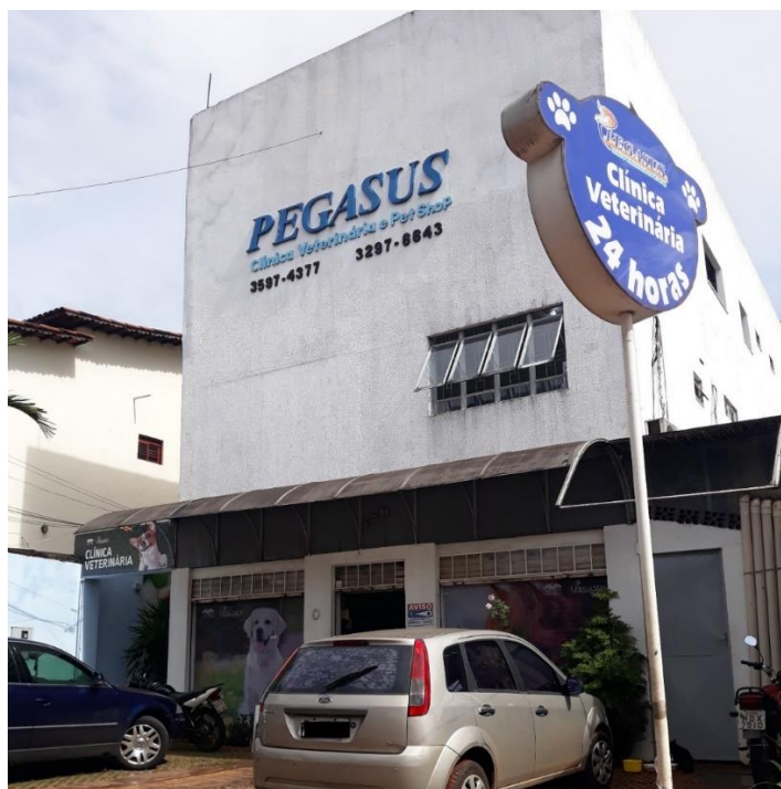
Figura 1- Fachada da Clínica Veterinária Pegasus.
