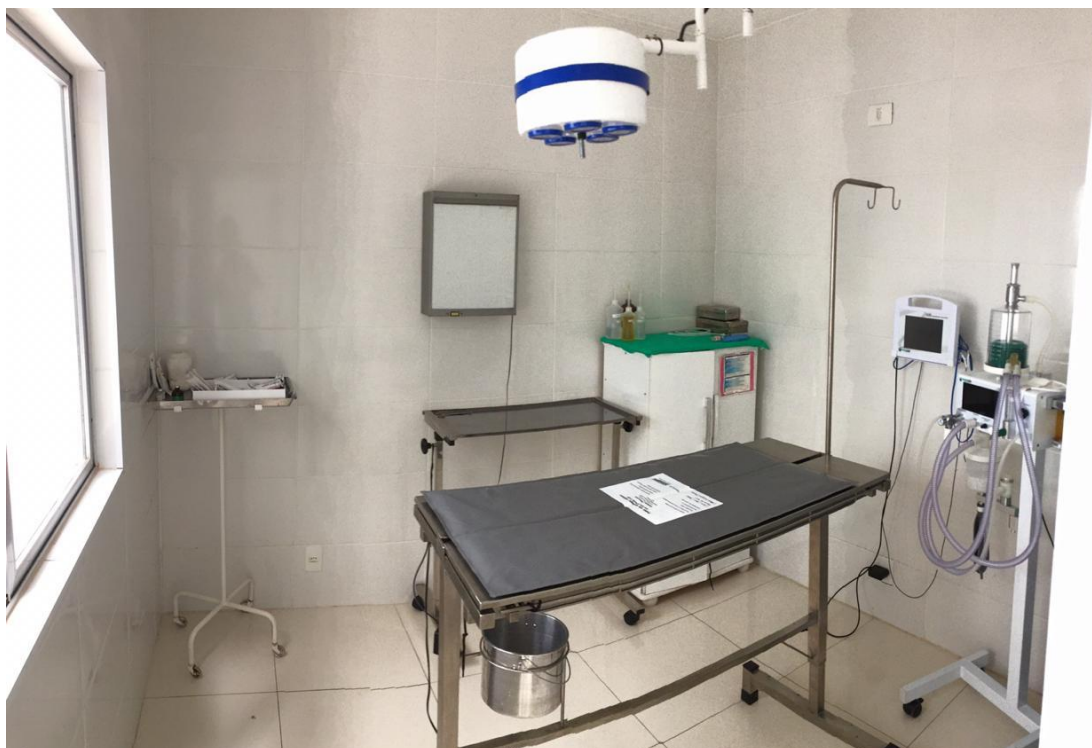
Figura 7 – sala de cirurgia da CLIMEVE: à esquerda mesa de instrumentos; negatoscópio; mesa auxiliar; armário com medicamentos; monitor multiparamétrico; aparelho de anestesia inalatória com ventilação mecânica.
