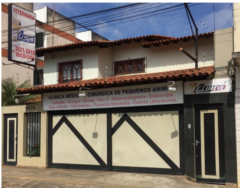
Figura 1- Entrada da CLIMEVE. O portão à direita dá acesso à clínica.
