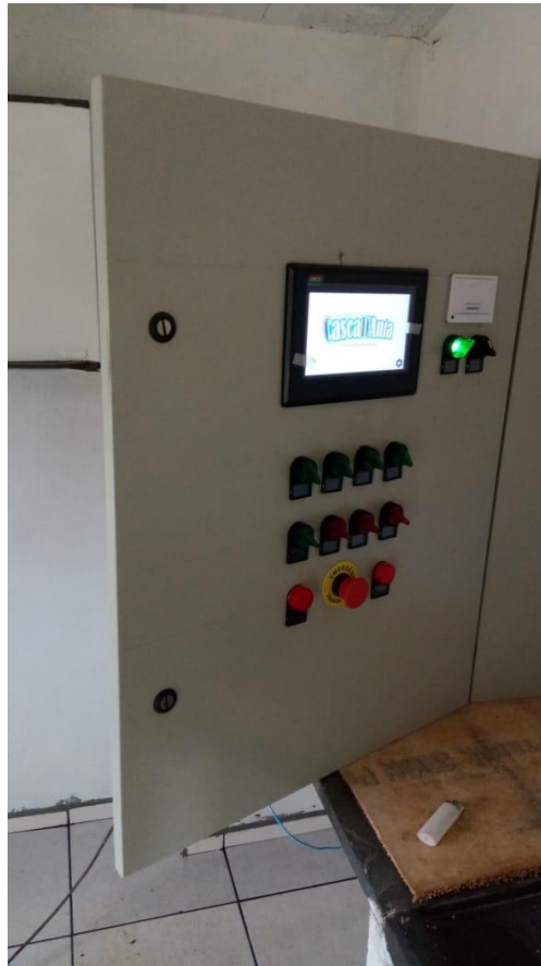
Figura 12 - Painel de controle. Processamento de leite
