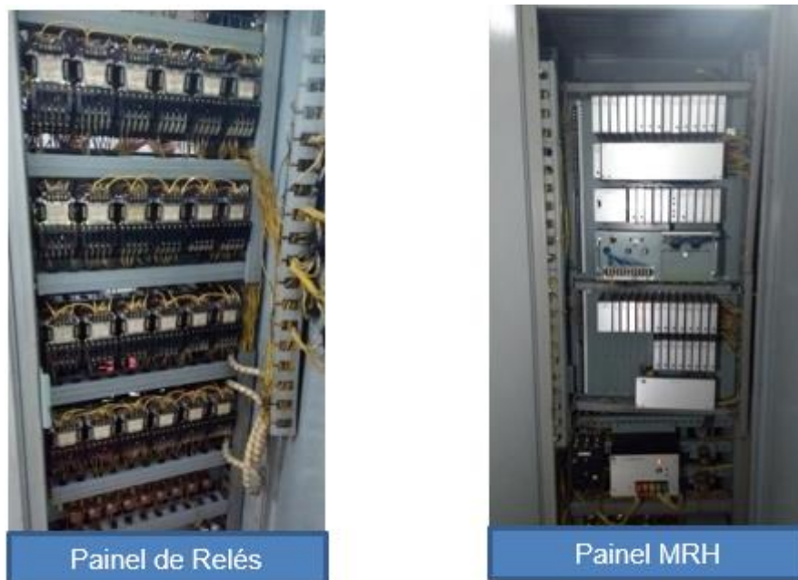
Figura 24 - Painéis MRH antes da implantação
